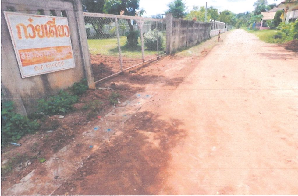
ภาพดำเนินการแล้วเสร็จ
